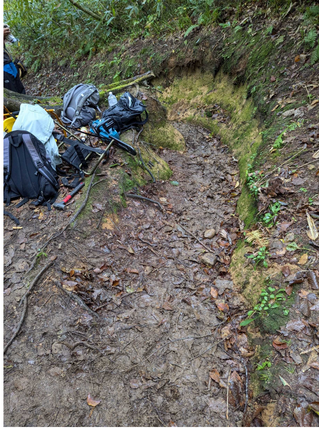
作業完了(完成ではない…)
