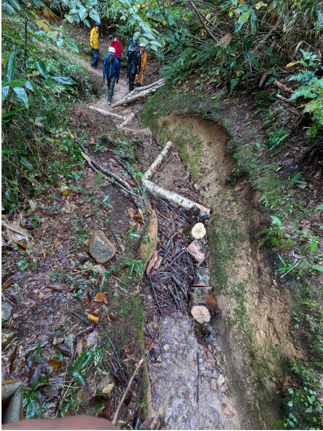
落ち葉、土砂などを充填していく
